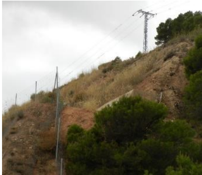
Σχήμα 23: Μεταλλικοί στύλοι διανομής ηλεκτρικής ενέργειας.
